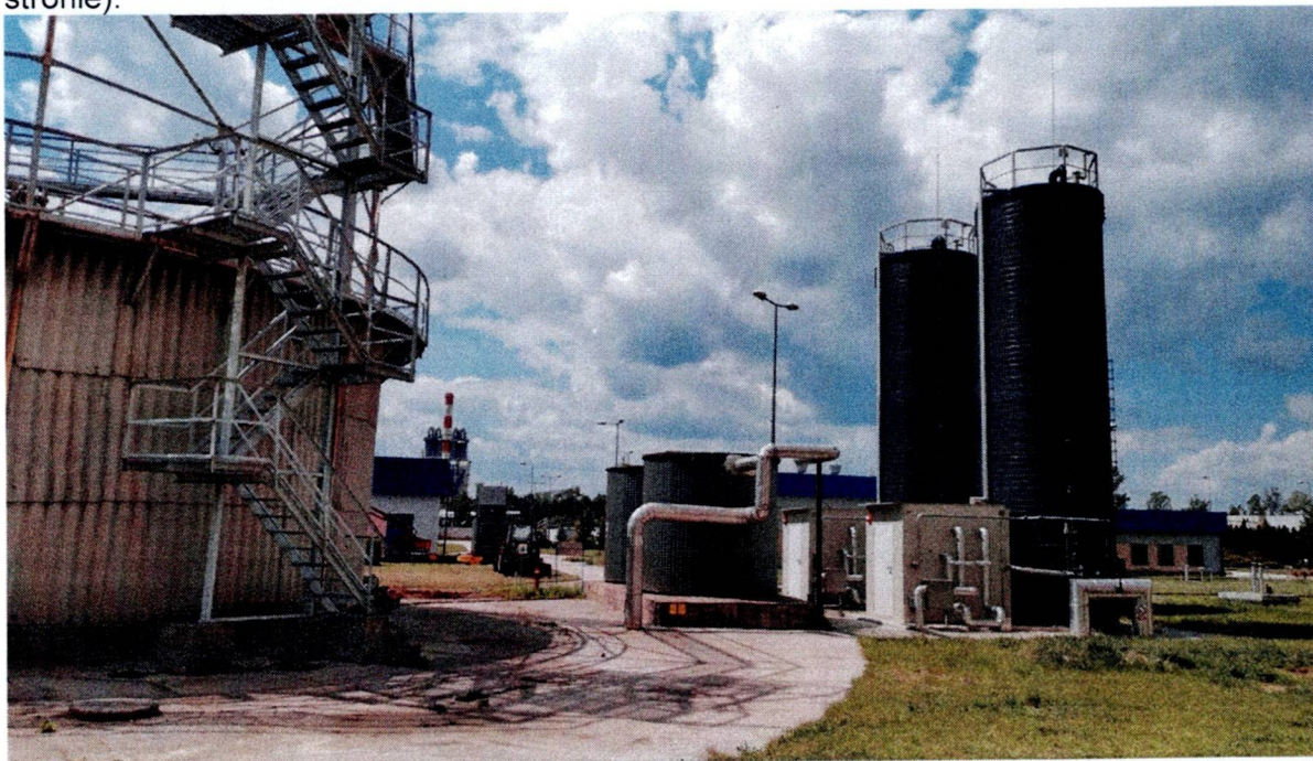
Zdjęcie nr 5. 2 Kolumny odsiarczalników z infrastrukturą do dalszej eksploatacji (po prawej stronie).
