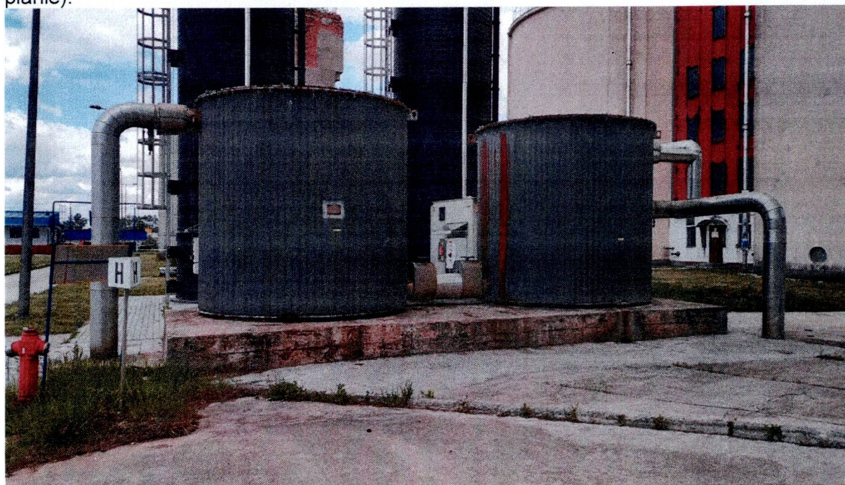
Zdjęcie nr 4. Odsiarczalniki z infrastrukturą towarzyszącą do demontażu (na pierwszym planie).
